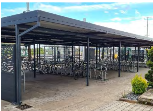
Racks à vélos de la gare de Thionville
