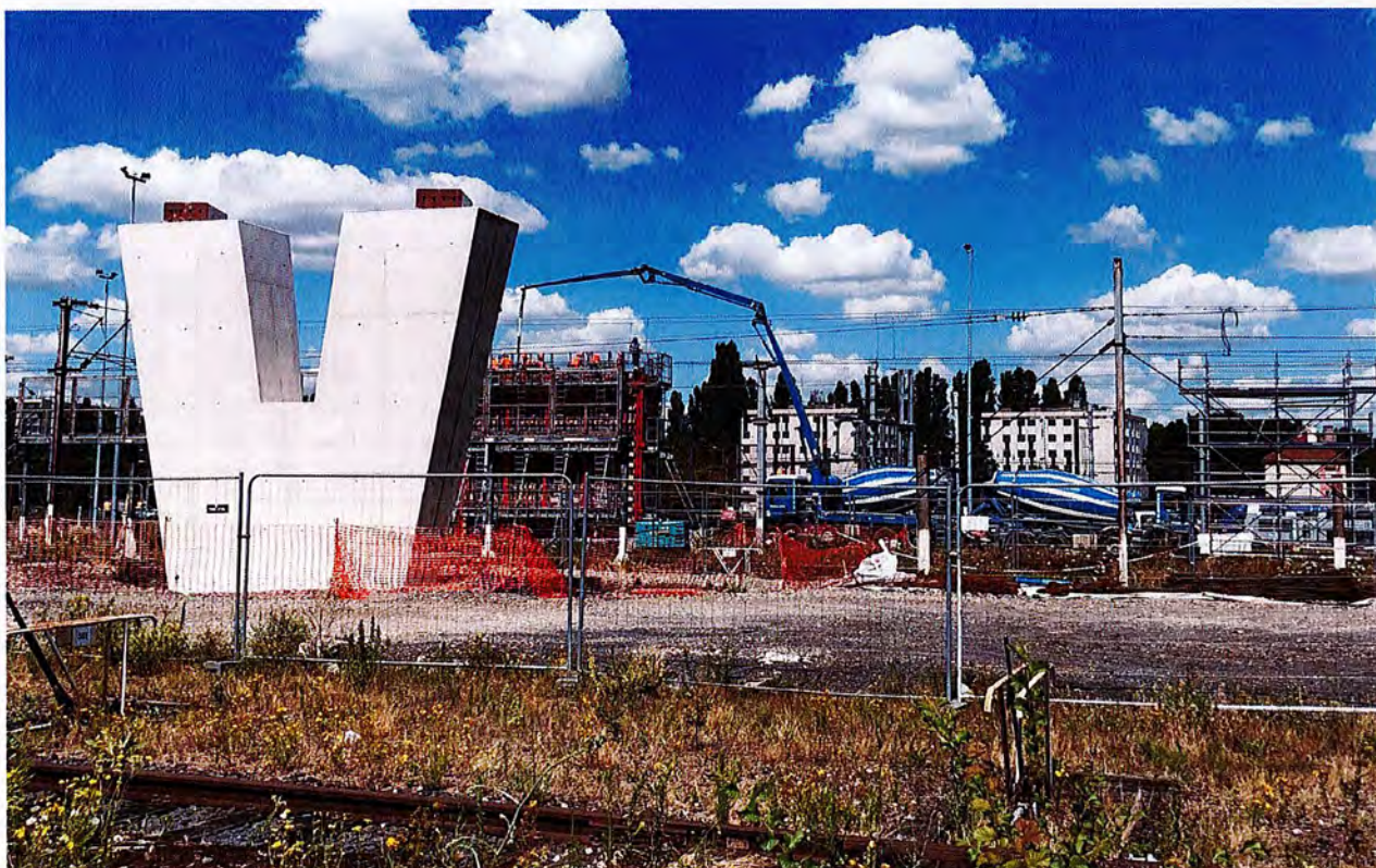
FIGURE 1 : PILES P4 ET P3 DE L'OA SNCF - 05/07/22
