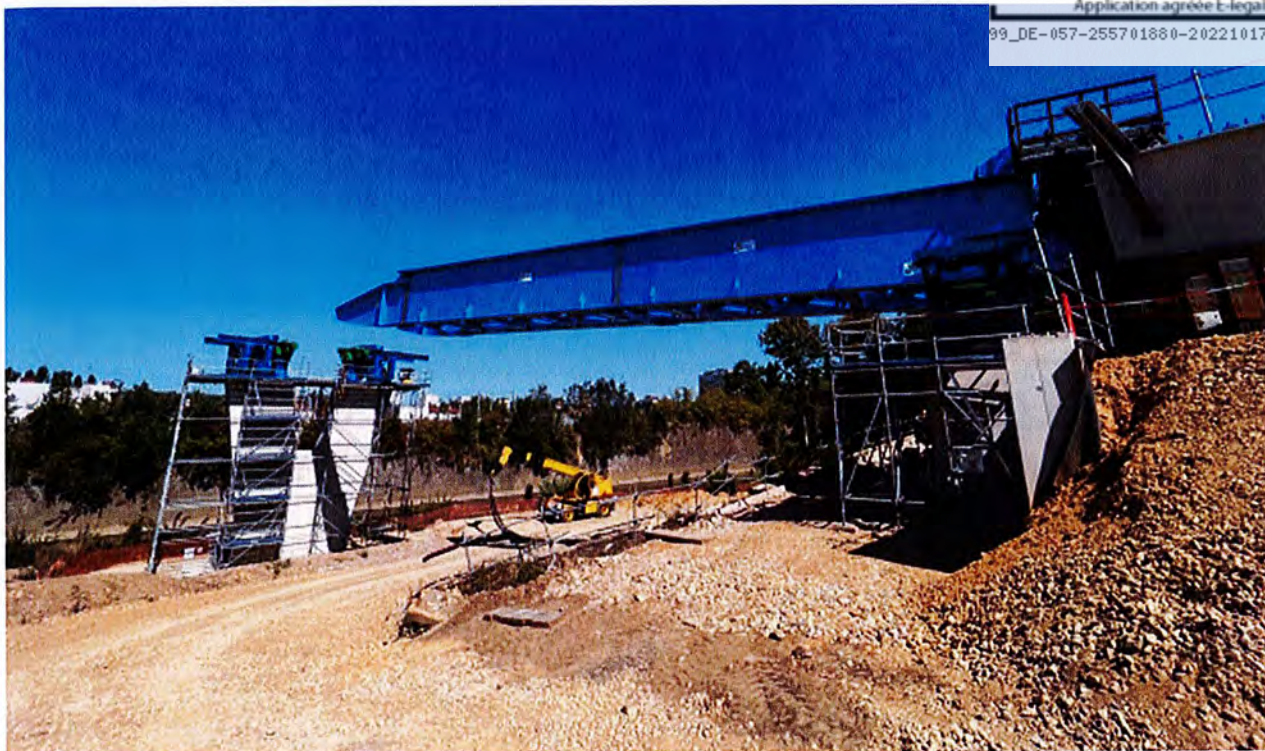
FIGURE 2 : LANÇAGE DE LA CHARPENTE METALLIQUE DE L'OA SNCF – 12/08/22
